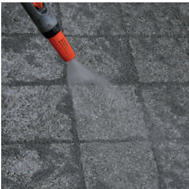
Bei Fugen von 3 - 8 mm das Einbringen in die Fugen mit dem Wasser- strahl unterstützen. Bei besonders schmalen Fugen den Wasserstrahl ent- lang den Fugenführen. Nachgesackte Fugen sofort mit frischen Material auffüllen.
