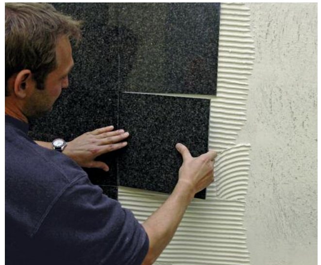
Wandverlegung von Naturwerksteinplatten mit PCI Carralight.
