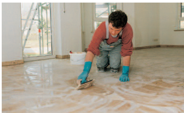
Naturwerksteinplatten mit dem Spezial-Fugenmörtel PCI Carrafug verfugen und Boden- und Wandanschlussfugen im System mit dem Silikon-Dichtstoff PCI Carrafem schließen.
