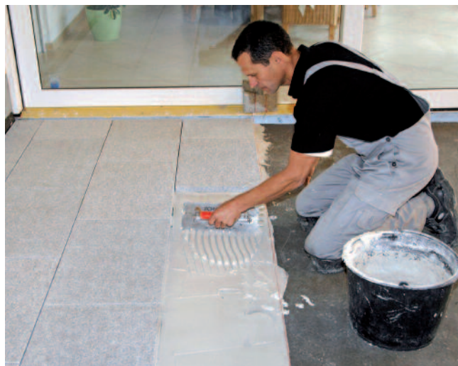
Mit dem weißen Verlegemörtel PCI Carrablott NT können auch kritische Naturwerksteinplatten sicher verlegt werden.
